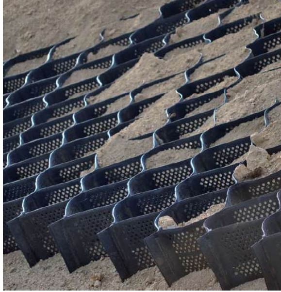
Figura 22. Sistema modulare geocellulare
