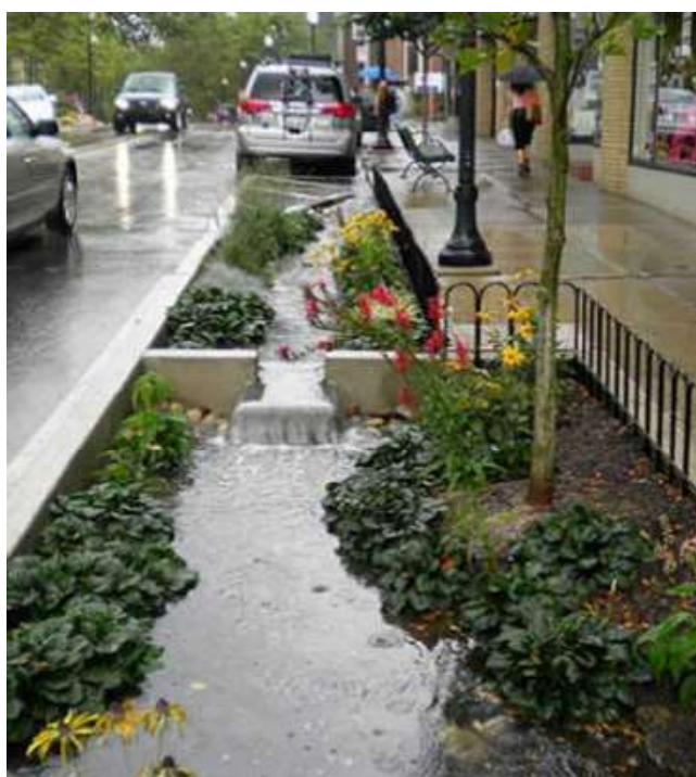
Figura 165. Rain Garden bordo stradale
