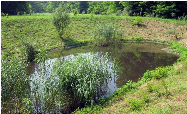
Figura 235. Bacino di infiltrazione e fitodepurazione
