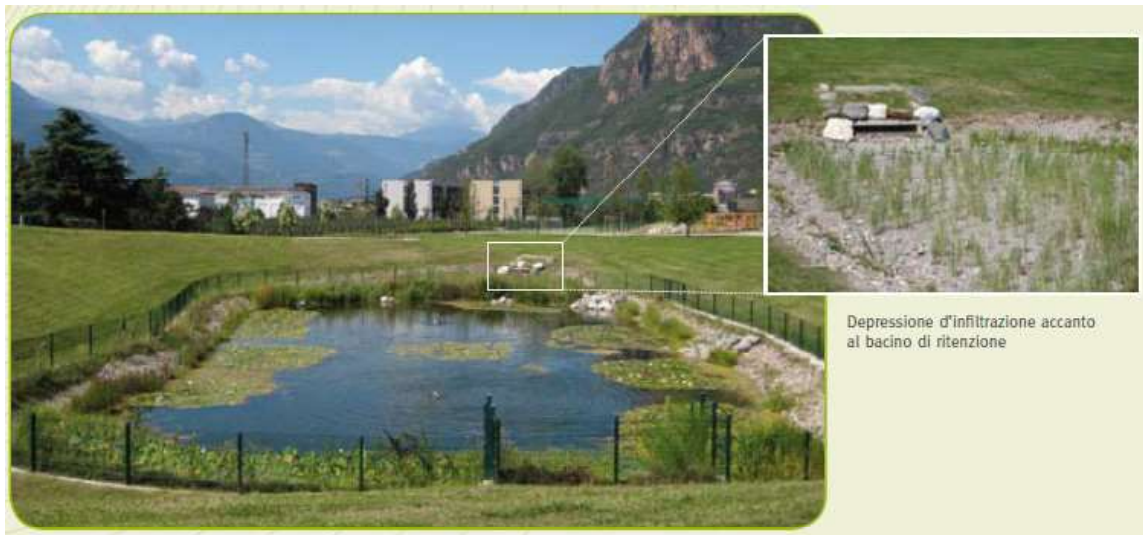
Figura 224. Bacino di ritenzione con infiltrazione artificiale
