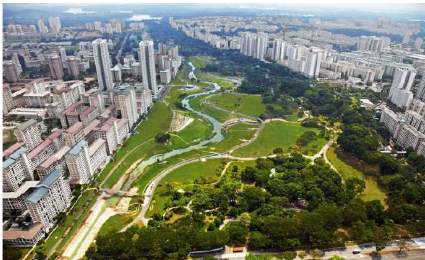
Figura 31. Rinaturalizzazione del Kallang River (Bishan Park), Singapore
