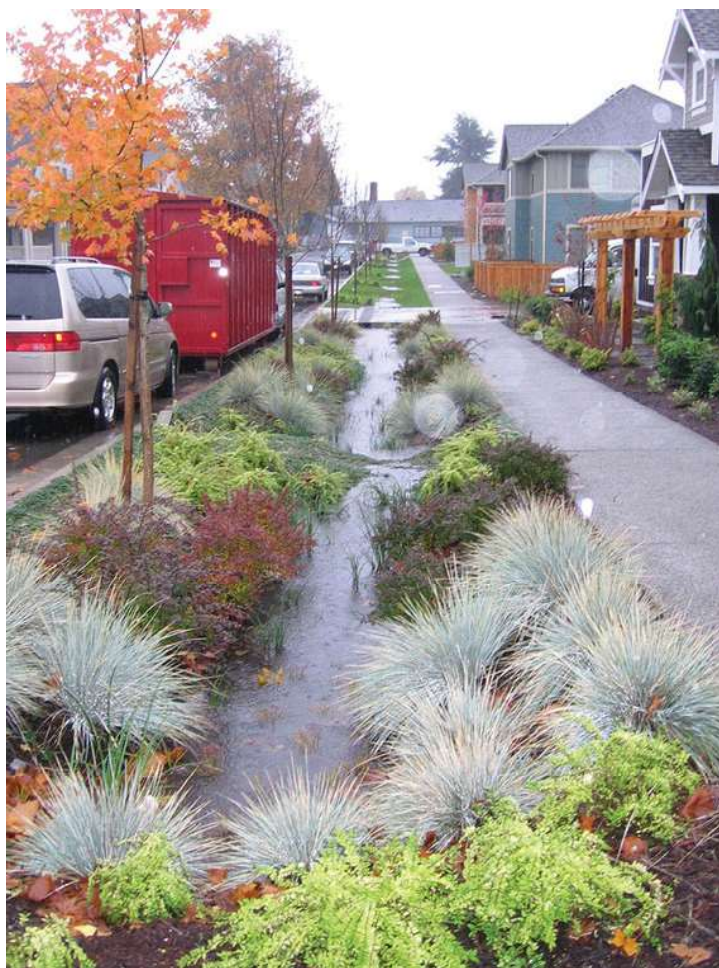
Figura 257. Bioswale parallelo alla strada. Può essere laterale o centrale, tra i due sensi di marcia
