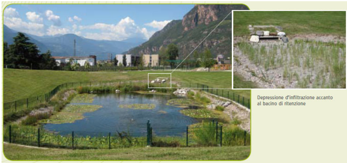
Figura 224. Bacino di ritenzione con infiltrazione artificiale
