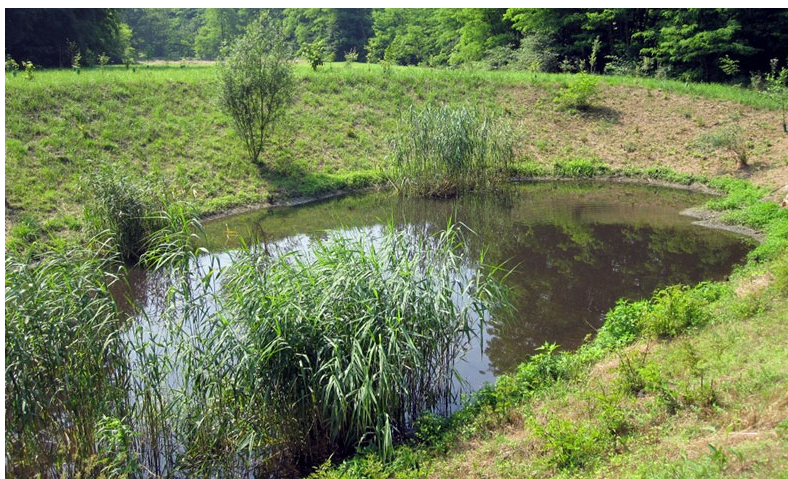
Figura 235. Bacino di infiltrazione e fitodepurazione
