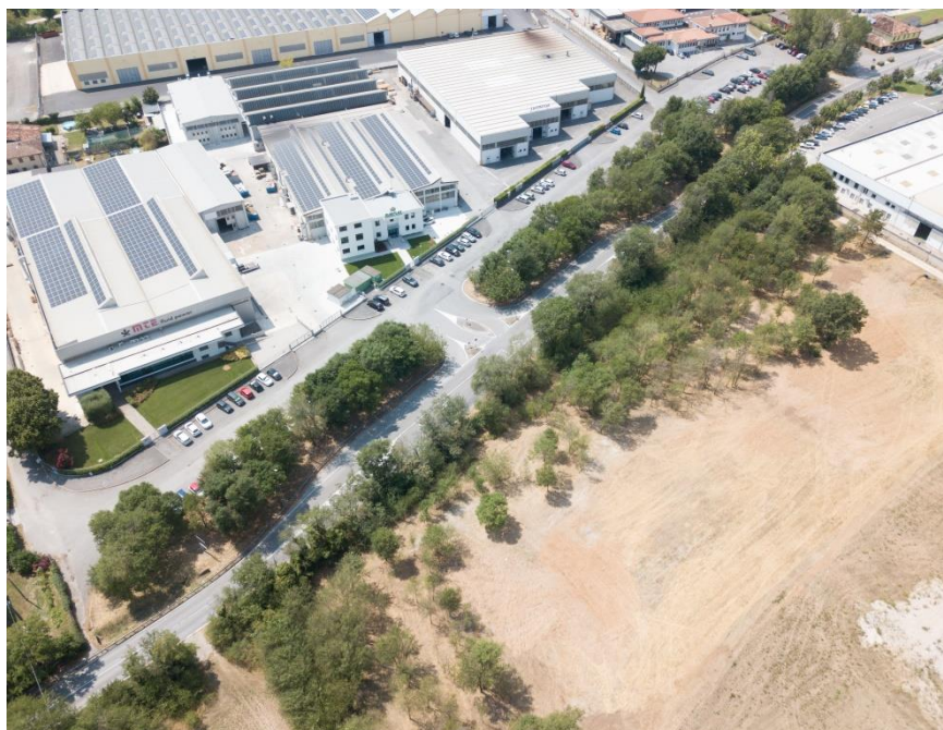
Immagine 19. Foto acquisita mediante volo con drone in data 16 luglio 2025.
