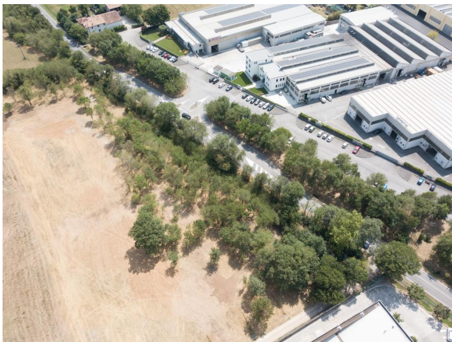
Immagine 18. Foto acquisita mediante volo con drone in data 16 luglio 2025.
