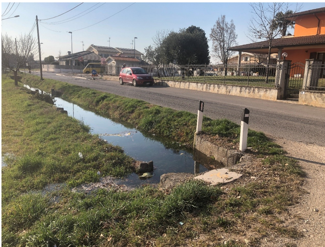
Figura 5: Tratto di canale a cielo aperto lungo via Sant'Eurosia
