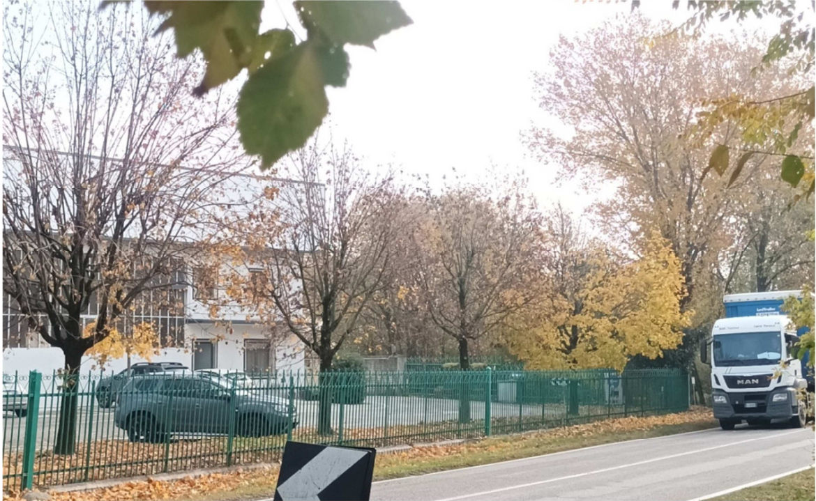
Fotografia 6. Recinzione fronte strada nella zona del capannone aziendale.
