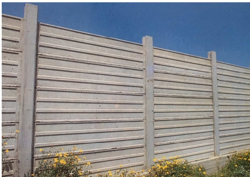
Immagine 9. Esempio di recinzione fatta con pannelli di calcestruzzo. Fonte: web.
